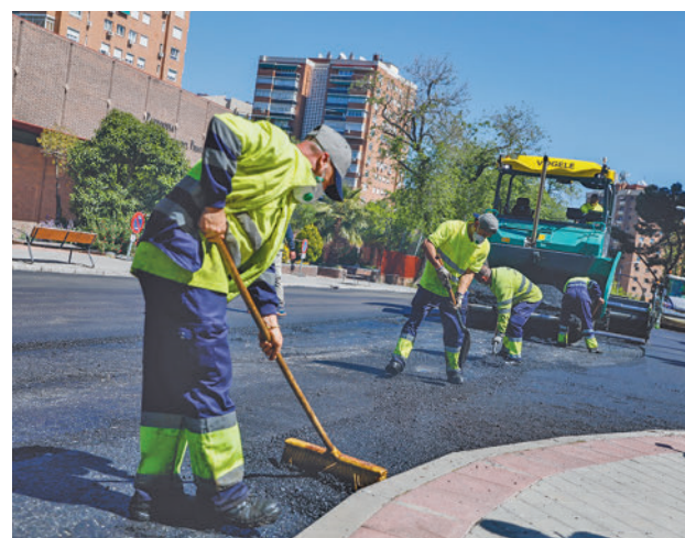
Varios operarios trabajan en la calle de Jazmín
