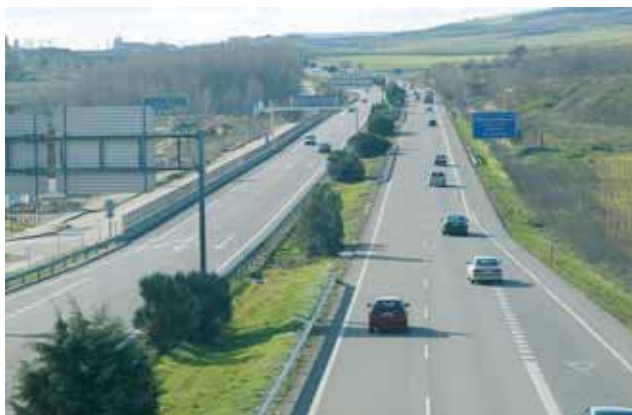
Las carreteras de la región recibirán mejoras y modernizaciones.
