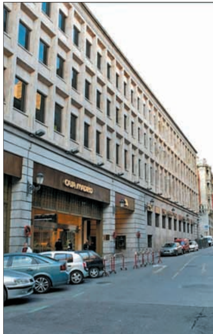
Sede central de Caja Madrid
