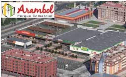
Las obras del Parque se encuentran prácticamente finalizadas.
