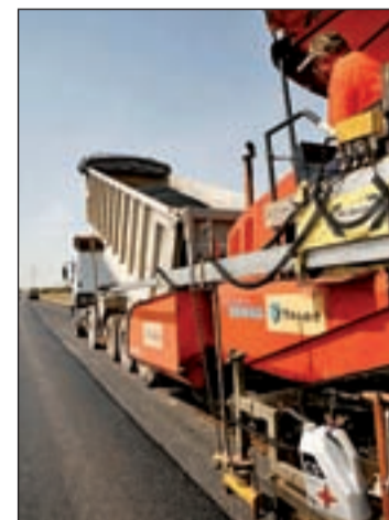
Obras de mejora en una carretera
