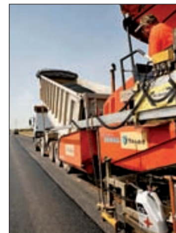
Obras de mejora en una carretera
