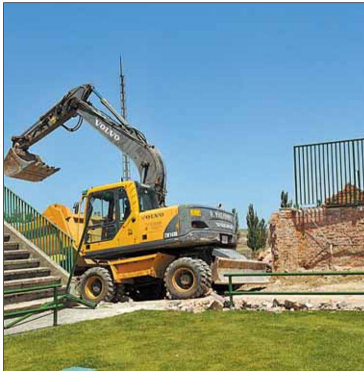
Parte de las gradas de La Albuera se encuentra en obras.
