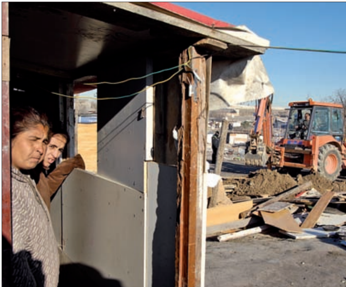
Un derribo en la Cañada Real Galiana OLMO GONZÁLEZ/GENTE
