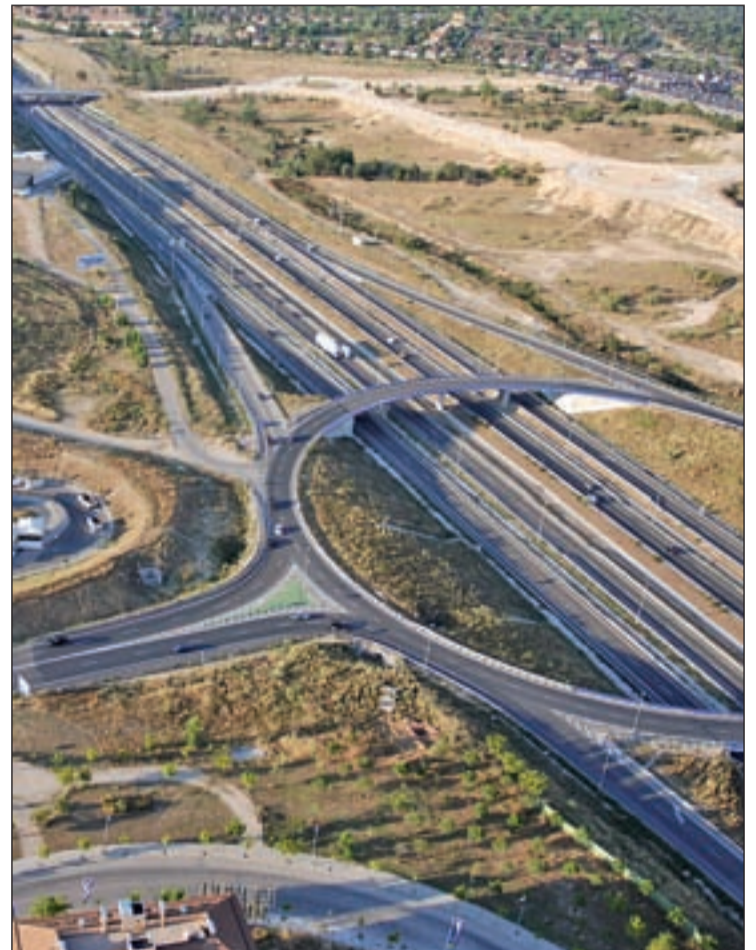
Uno de los tramos de la M-50 a su paso por Boadilla
