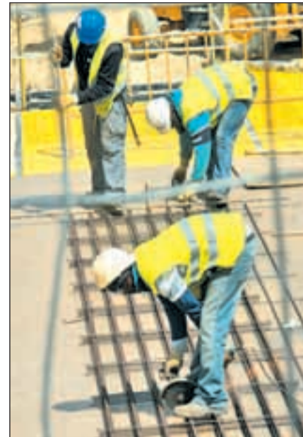
Trabajadores de la construcción
