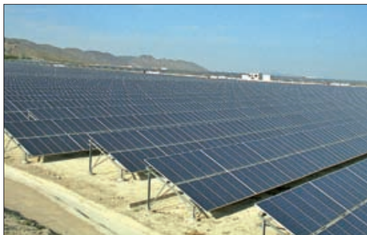
OTRO NEXO VERDE Las obras de otra planta solar térmica, que tendrá capacidad para producir electricidad para 16.000 hogares y que se construye en Calasparra, están en su fase final y se pondrán en funcionamiento en 2012.
