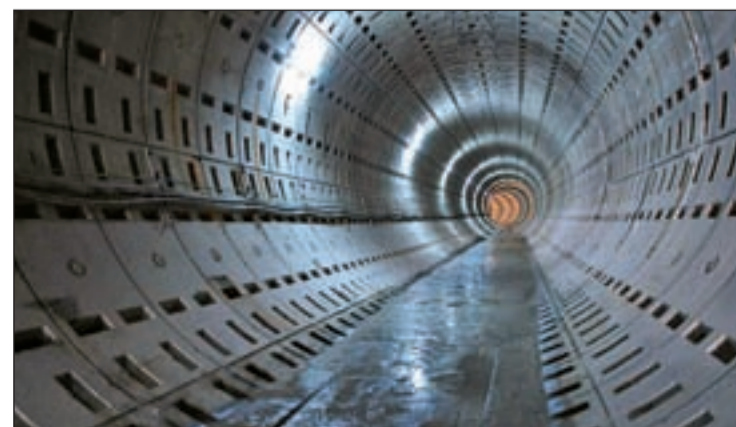
Imagen del nuevo colector
