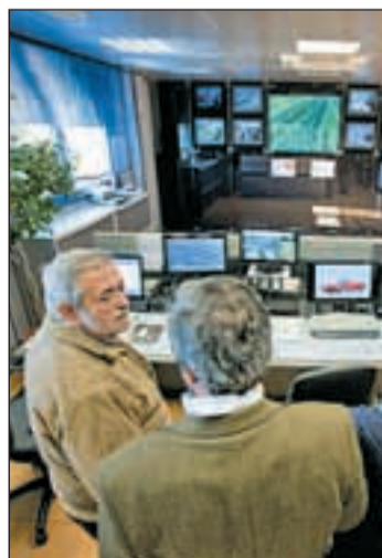
Centro de control de la M-501
