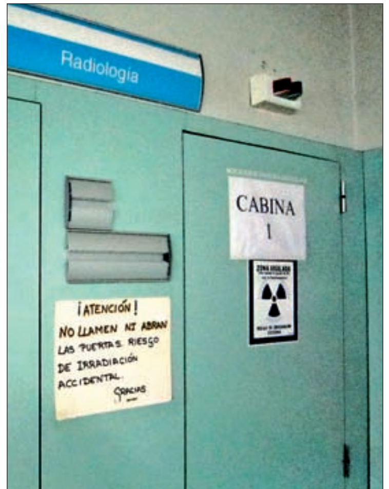
La sala de Rayos X del Hospital Cerro del Aire de Majadahonda
