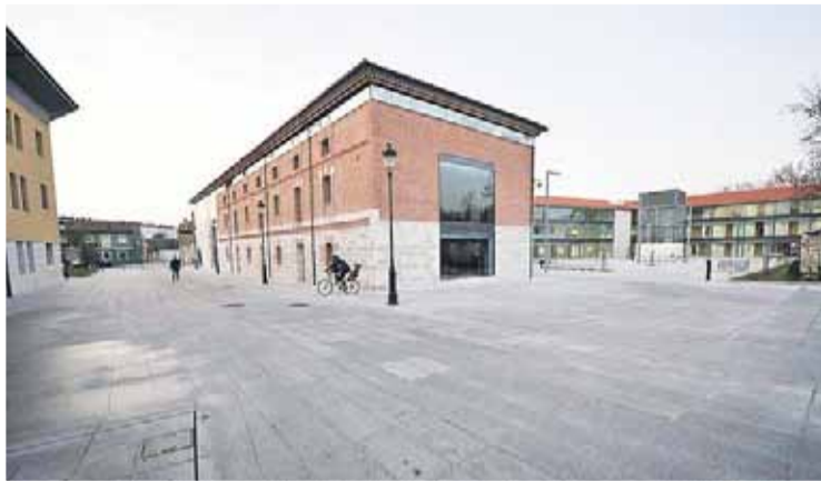
El edificio cuenta con cerca de 7.000 metros cuadrados y diversas plantas.
