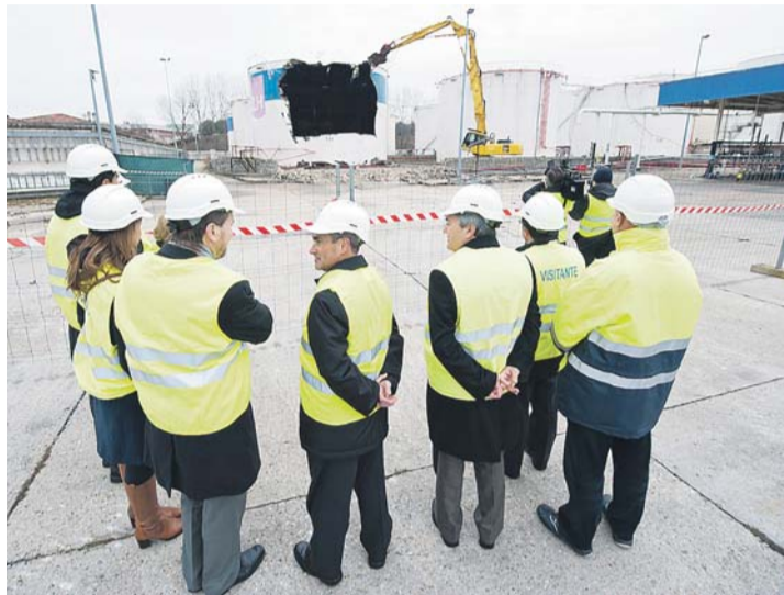
El desmantelamiento incluye el desmontaje de todos los tanques y equipos.
