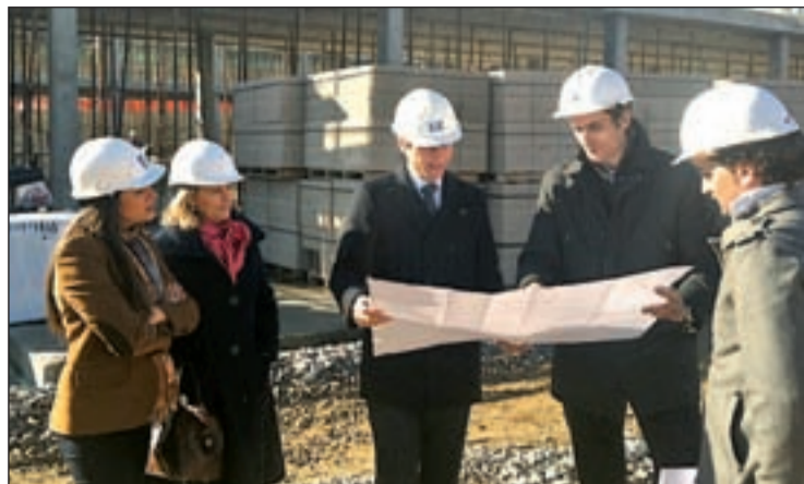
Visita de Terol a las obras del ambulatorio
