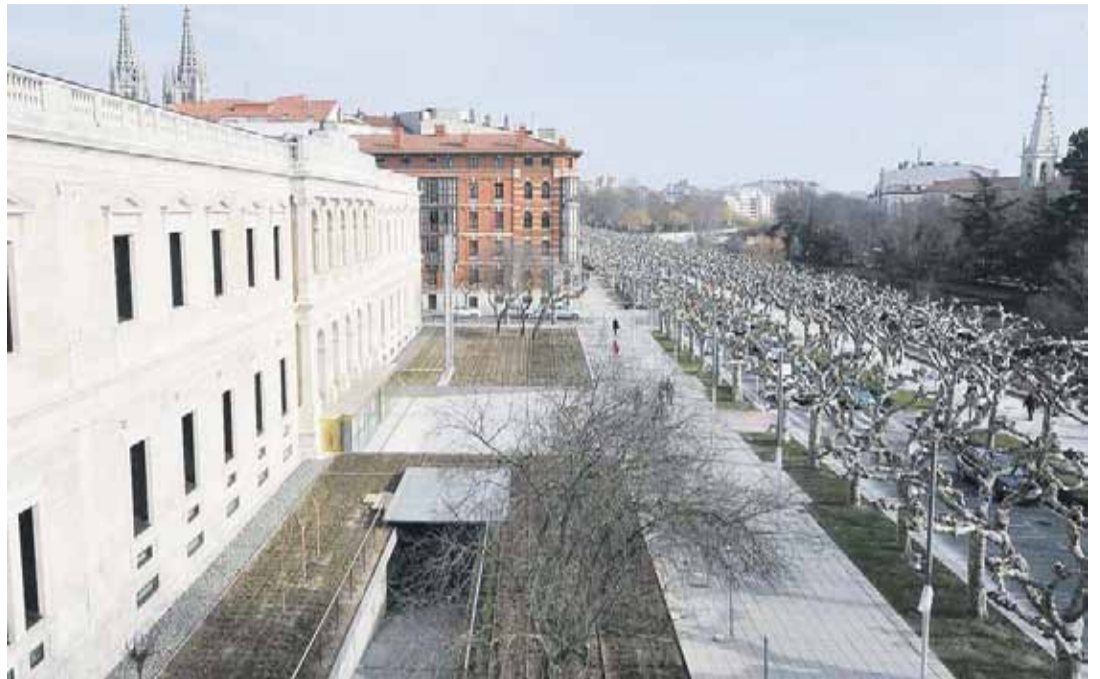
La rehabilitación del Palacio de Justicia ha supuesto la eliminación de las escaleras de acceso.
