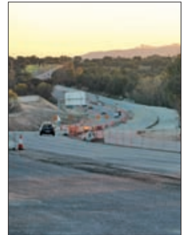
Foto de archivo obras M-501
