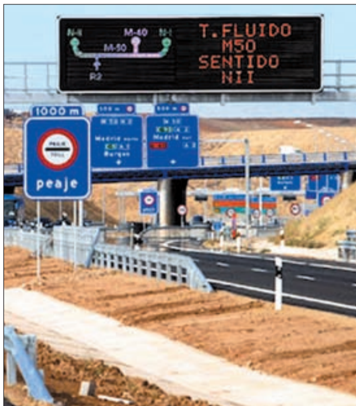
Una carretera de peaje
