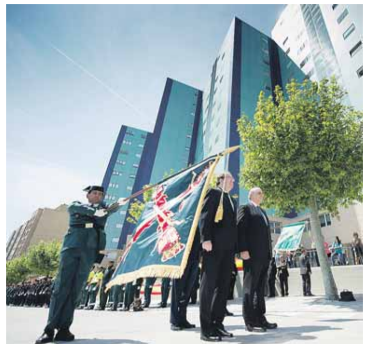
La Casa Cuartel ha sido objeto de una inversión de 15 M€ en su rehabilitación.
