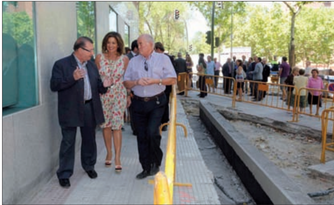
La primera edil camina junto a una de las obras de mejora de las infraestructuras urbanas
