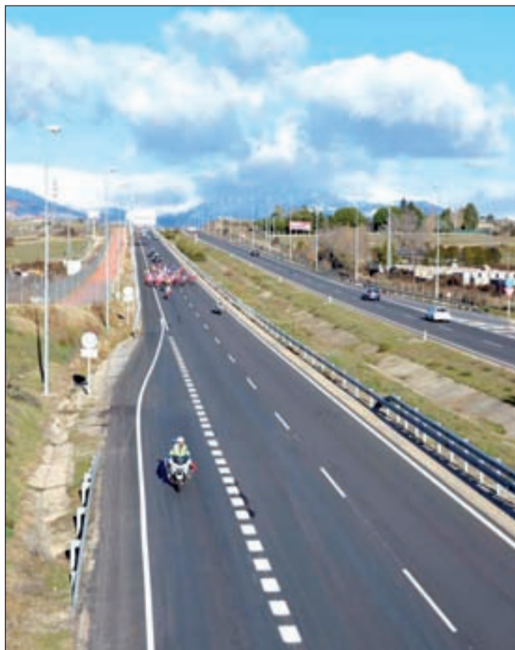
Zona de la M-607 donde se construirá el próximo acceso
