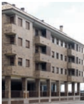
Edificio de Básico Homes.
