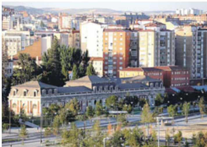
Las obras en la antigua Estación se desarrollarán durante el año 2014.
