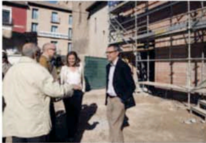
Visita a las obras de la Iglesia de San Bartolomé.
