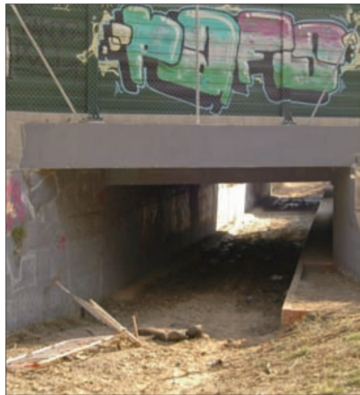
El túnel que conecta el barrio con el parque Lineal del Manzanares
