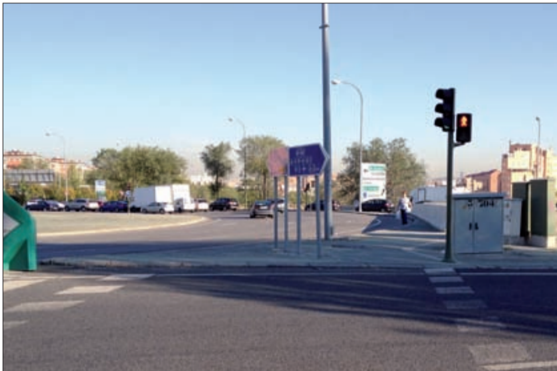
Una vecina utiliza el arcén de la glorieta para llegar al distrito de Villaverde desde Usera LUCA JIMÉNEZ
