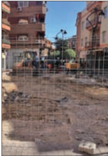
Obras de remodelación
