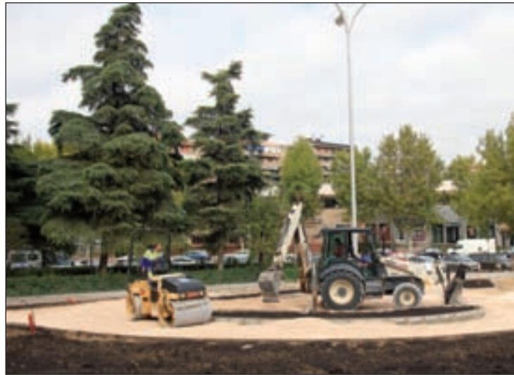
Los trabajos ya han comenzado
