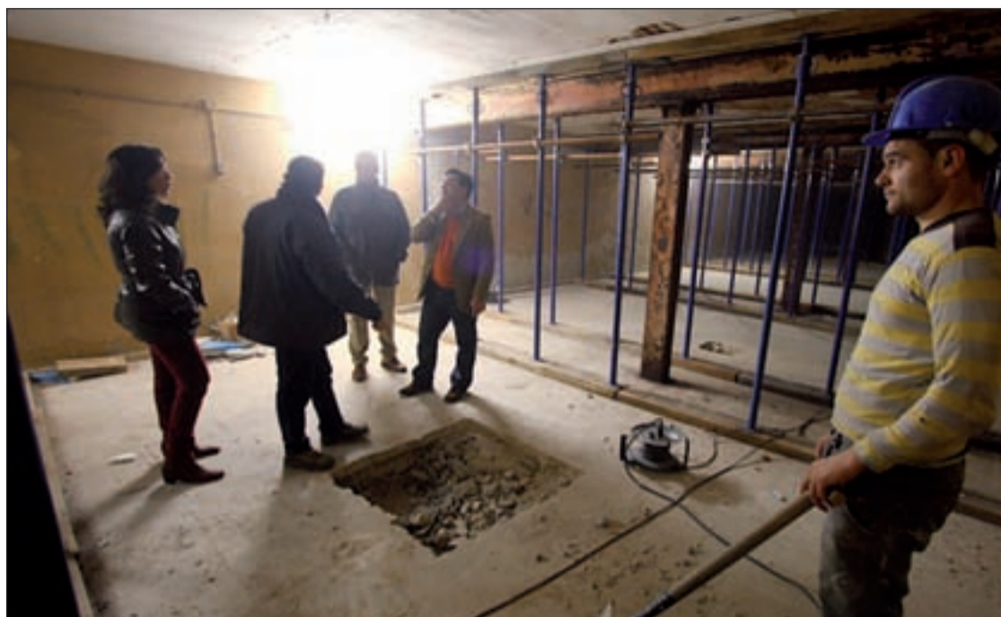
El concejal David Erguido comprobó sobre el terreno la marcha de las obras en el recurso municipal
