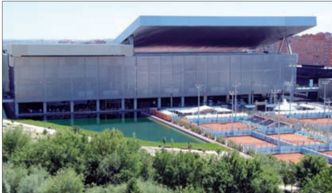
La asociación Barriada de San Fermín critica que la instalación vive de espaldas a los vecinos
