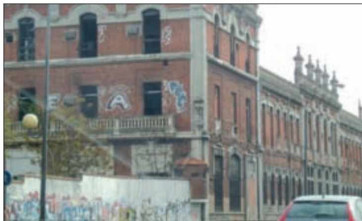
Las antiguas instalaciones militares de Campamento
