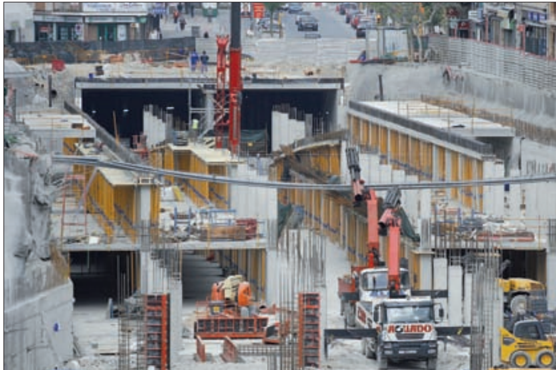
Imagen del túnel-parking Honorio-Lozano y Batalla de Bailén de Collado Villalba
