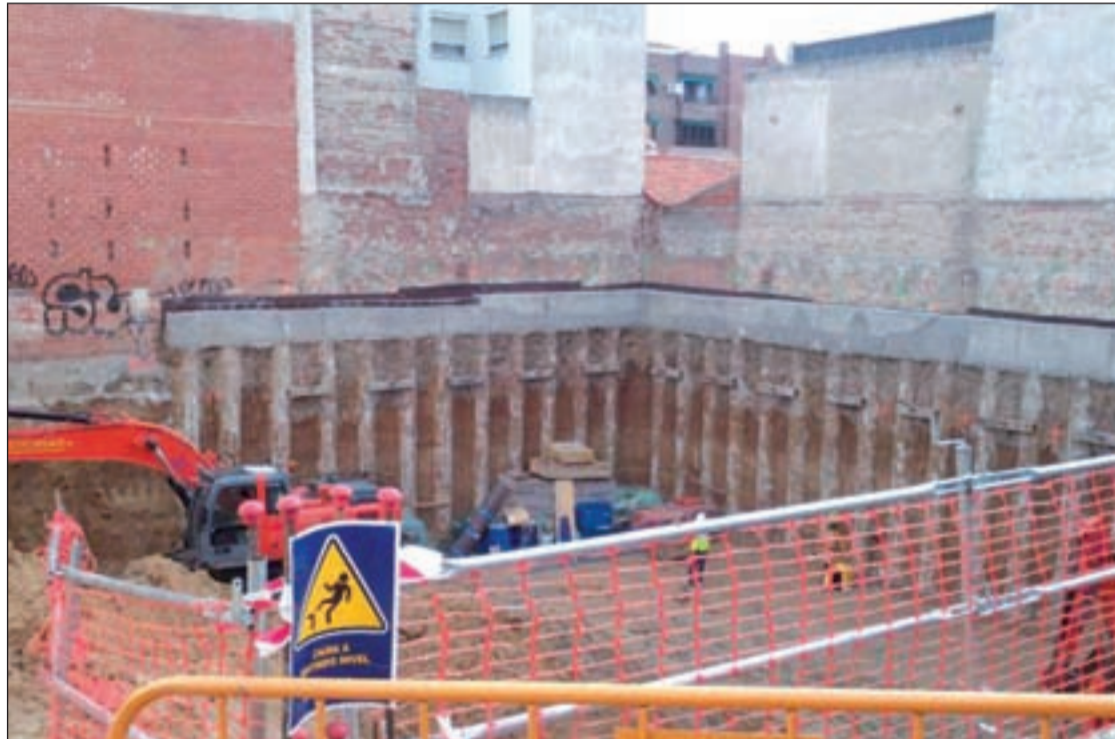
Obras donde se ha encontrado el obús
