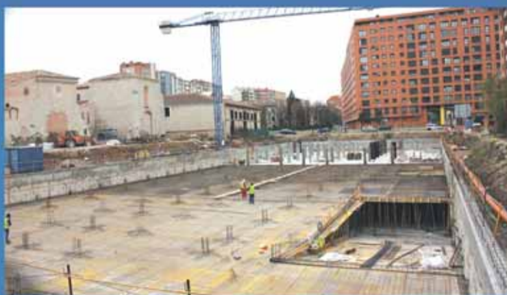
Obras del parking de la Zona Sur
