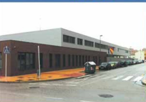
Nuevo Colegio en Fuentecillas SEPTIEMBRE 2012
