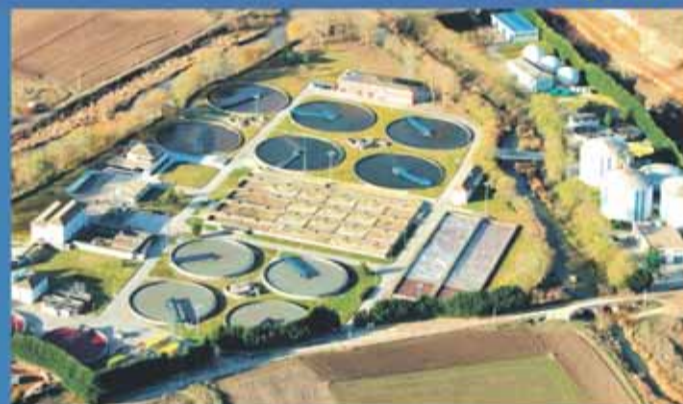
Adjudicada la Ampliación de la Depuradora DICIEMBRE 2012
