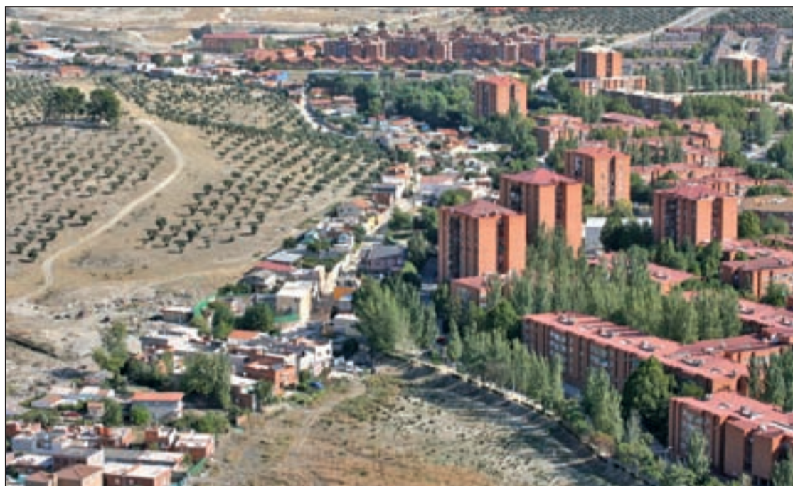
Vista de la Cañada Real
