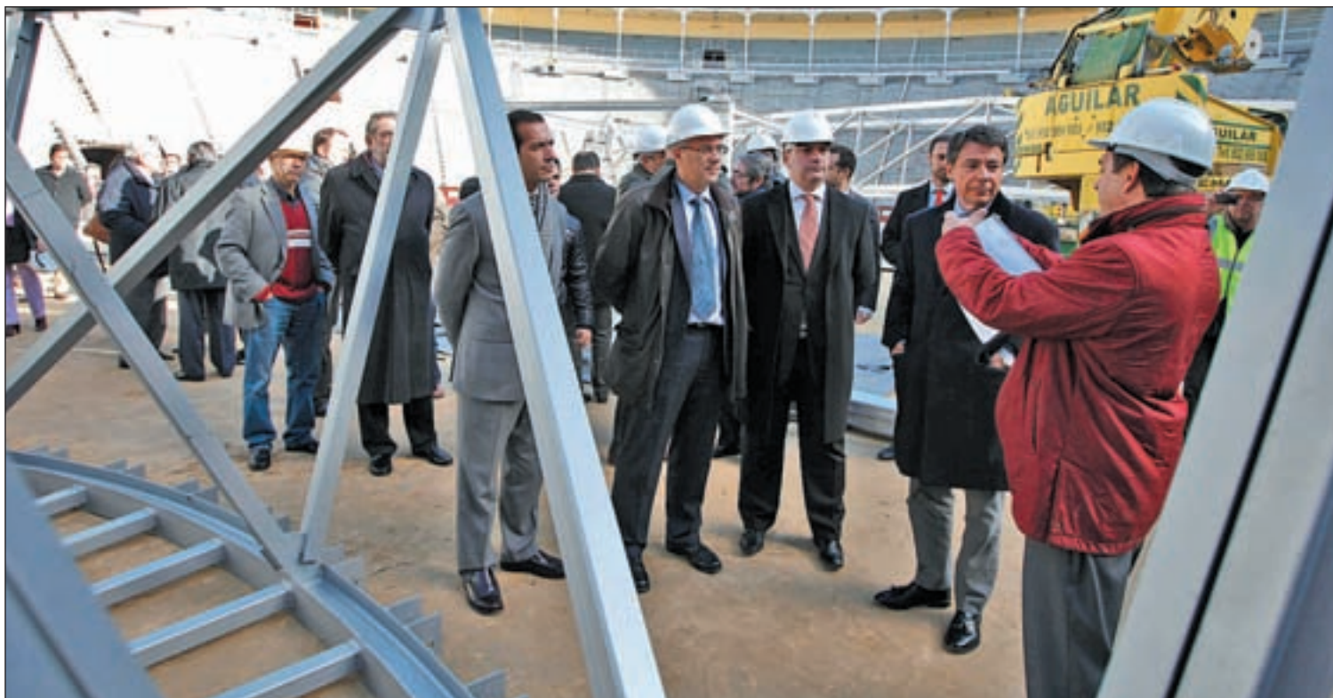
Ignacio González, en su visita al coso el pasado otoño durante la colocación de la estructura
