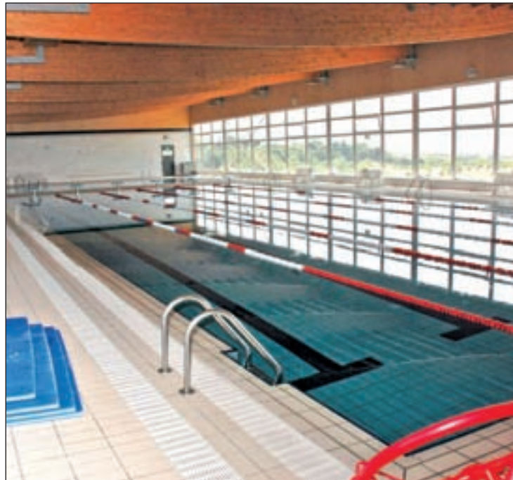
La piscina climatizada, antes de su cierre por deficiencias
