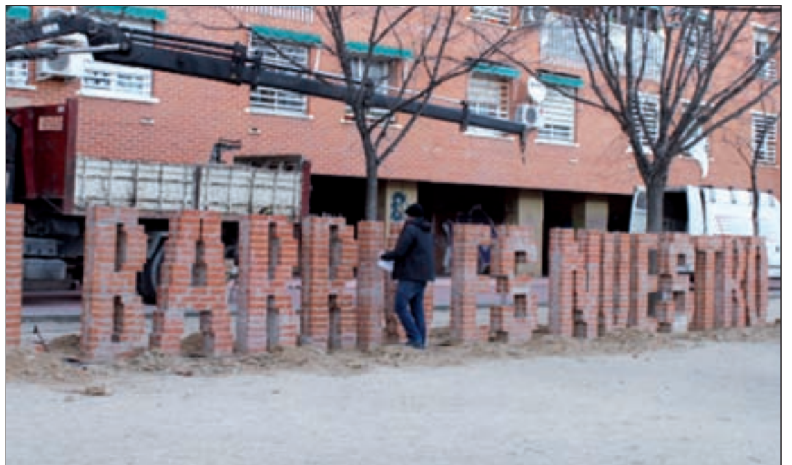
Un momento de la instalación del elemento ornamental situado en el barrio vallecano de Palomeras
