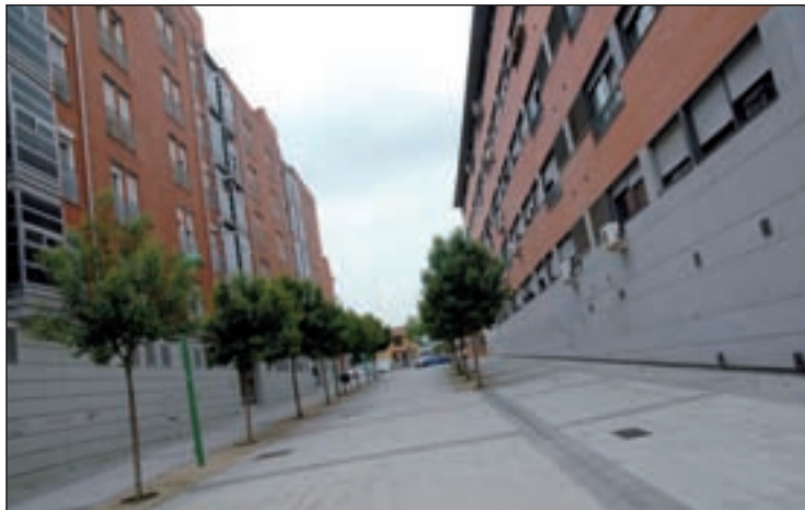
Viviendas del IVIMA
