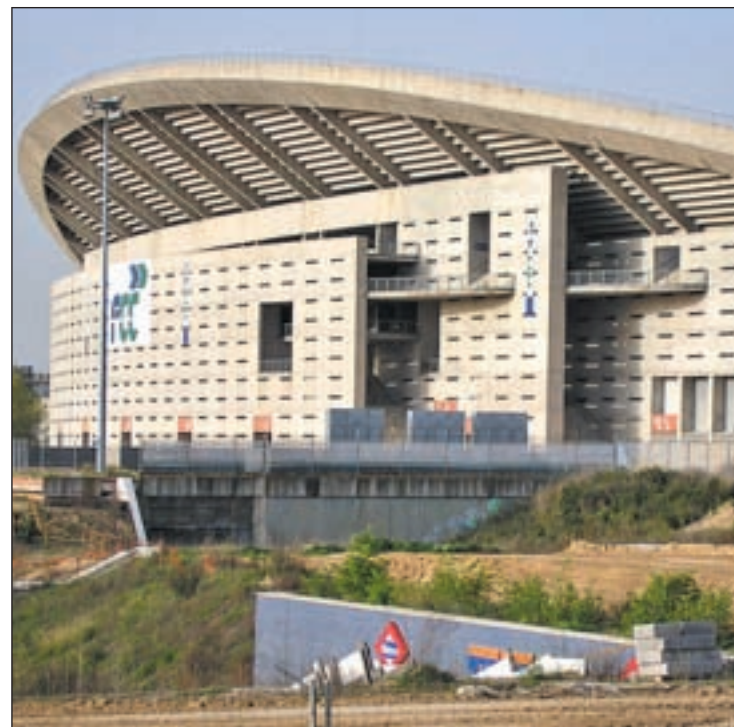
Estación de Metro de Estadio Olímpico
