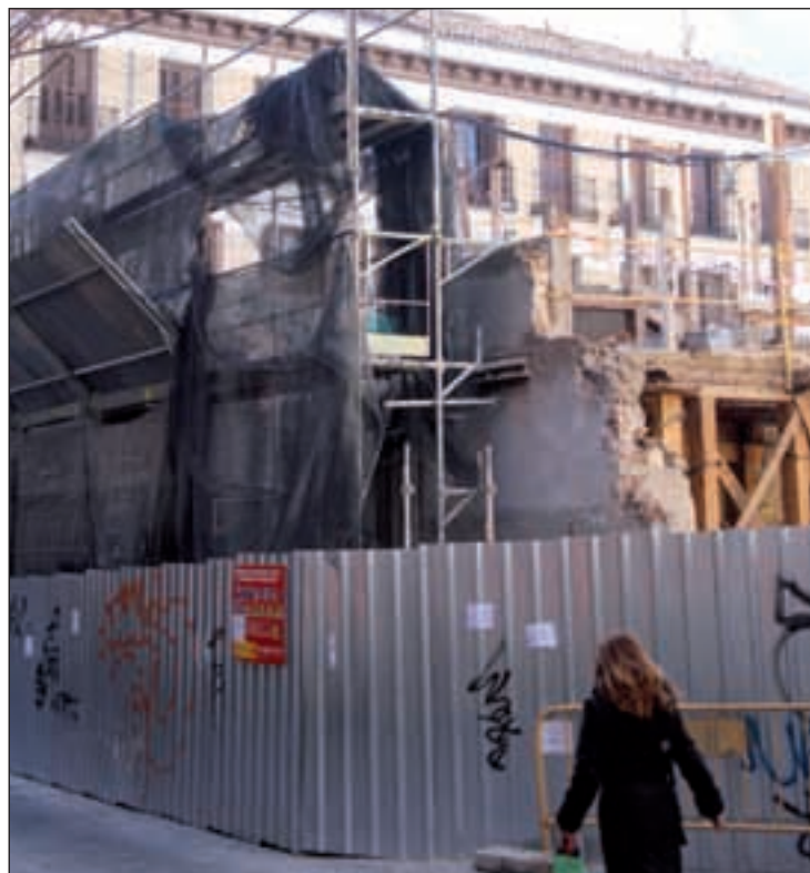
El derribo ha supuesto un coste de unos 250.000 euros
