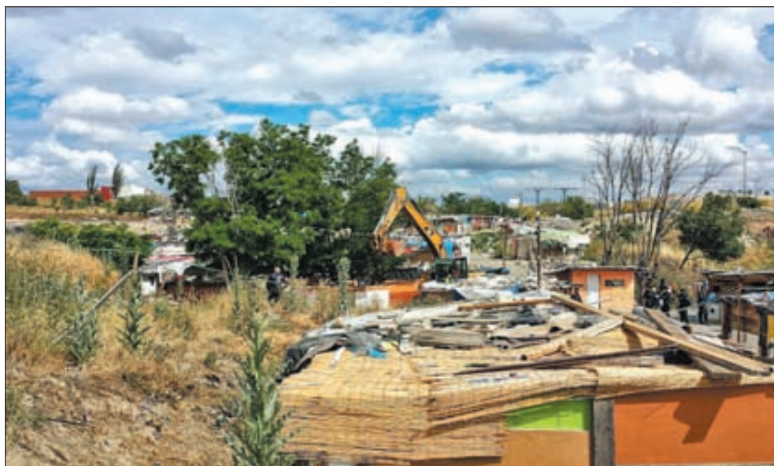
Las excavadoras derribaron cuatro chamizos la semana pasada en El Gallinero
