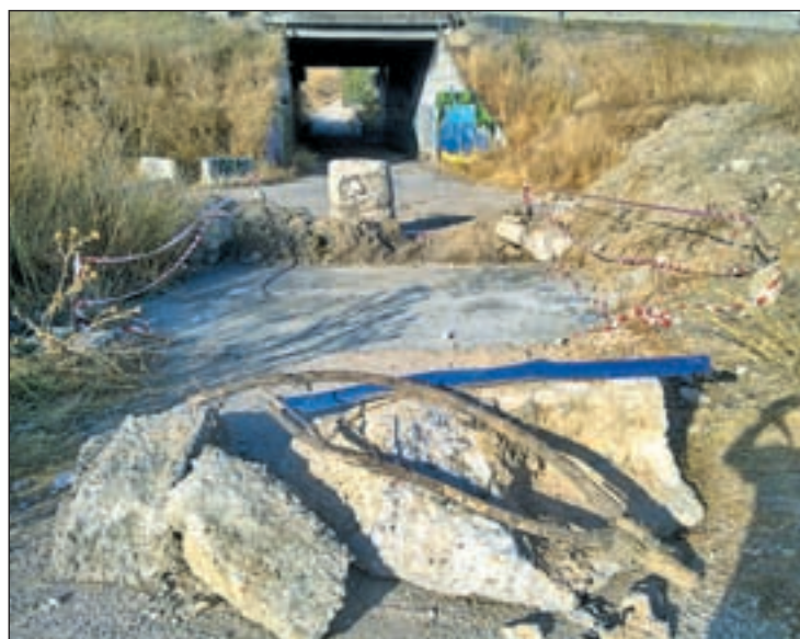
Estado actual del acceso a la altura de la calle del Zafiro
