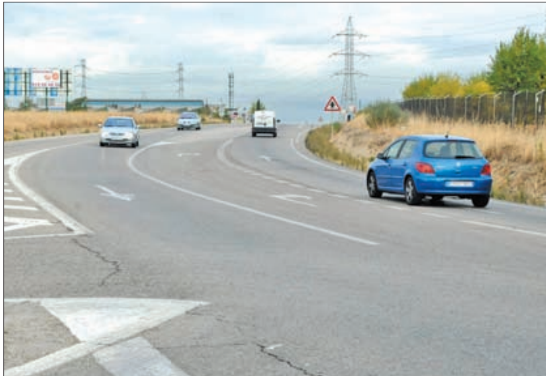
Uno de los tramos más peligrosos de la M-856
