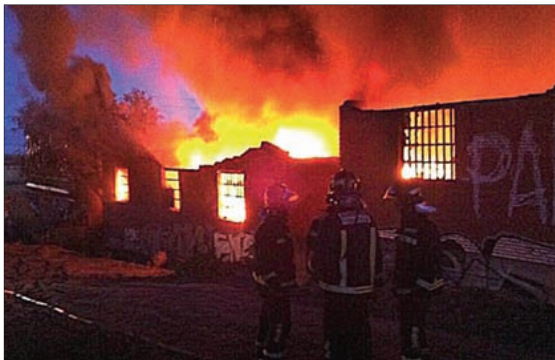
Incendio en nave Fuenlabrada
