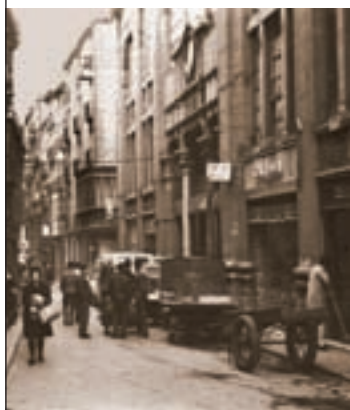
Fachada librería Balmes, hacia 1965
