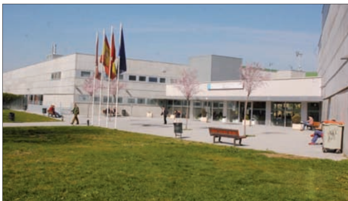
La entrada principal del Centro Deportivo Municipal de Gallur, en el distrito de Latina
