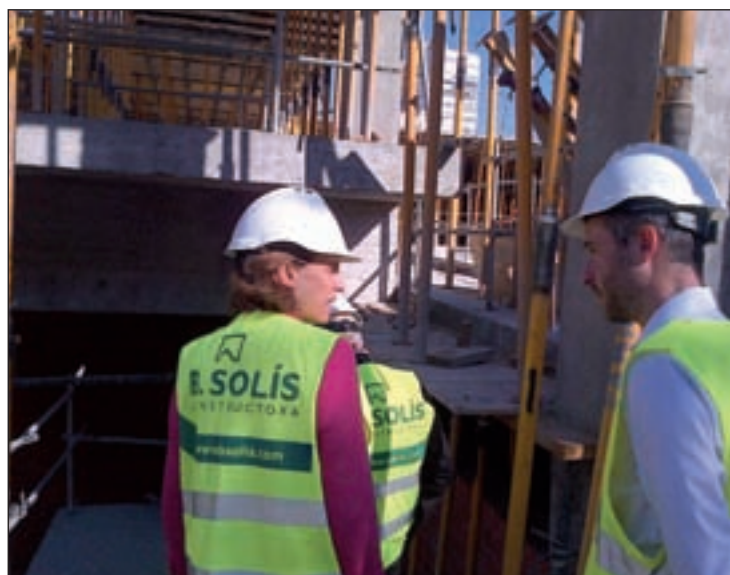
VISITA DE MARTÍNEZ-CUBELLS a las obras de Vallehermoso el pasado mes de septiembre. Entonces, la concejal de Chamberí aseguró que todo transcurriría "en tiempo y forma". Las obras comenzaron en julio de 2012 y se trata de las únicas instalaciones municipales del distrito.
