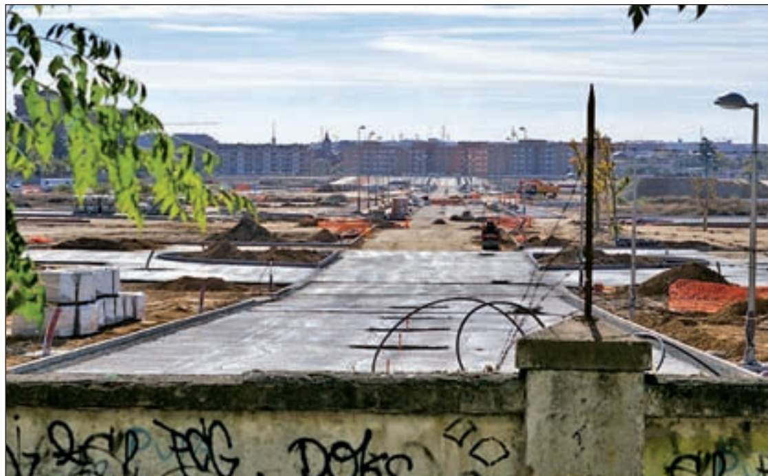
Las obras de uno de los bulevares del nuevo barrio situado en los antiguos cuarteles MARCO
