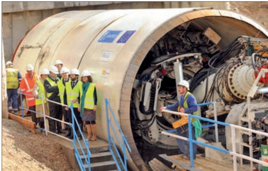
Botella, en el inicio de las obras
