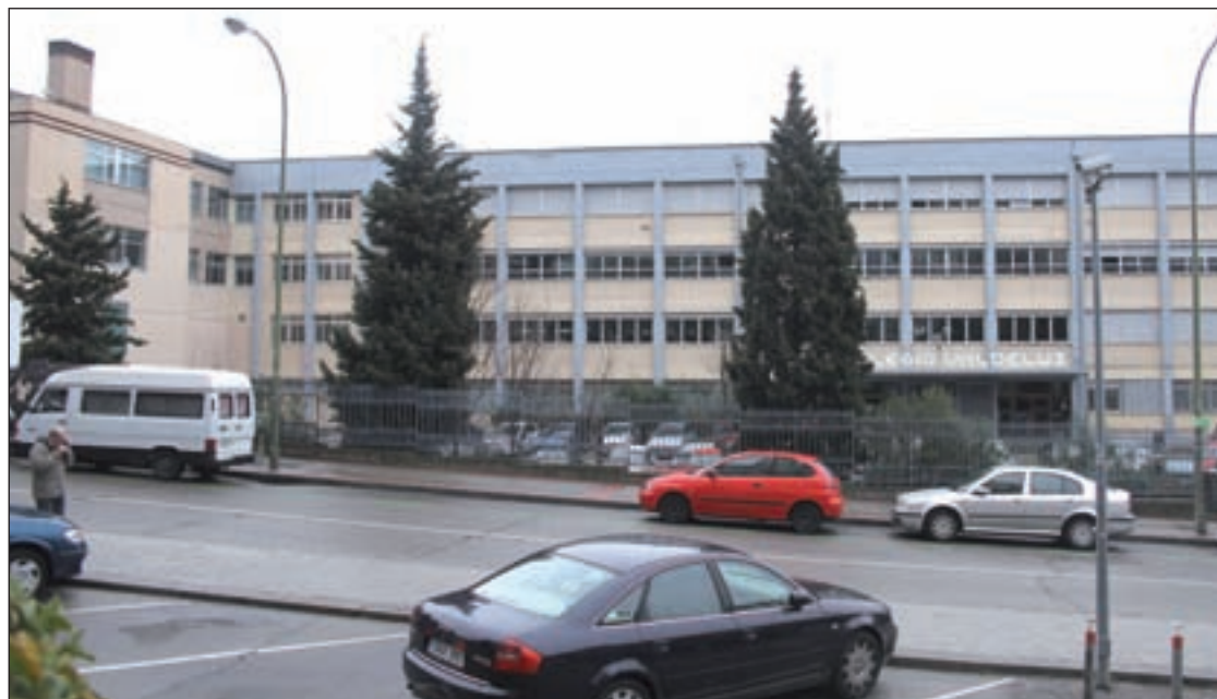
Fachada del colegio ubicado en el barrio del Pilar RAFA HERRERO/GENTE
